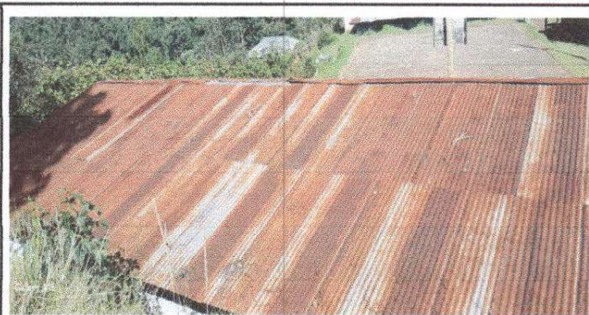
Foto 2: Modulo 2 Sustitucion por lamina troquelada calibre 26
