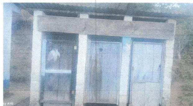
Foto 8: Sustitución de lámina por lámina troquelada calibre 26
