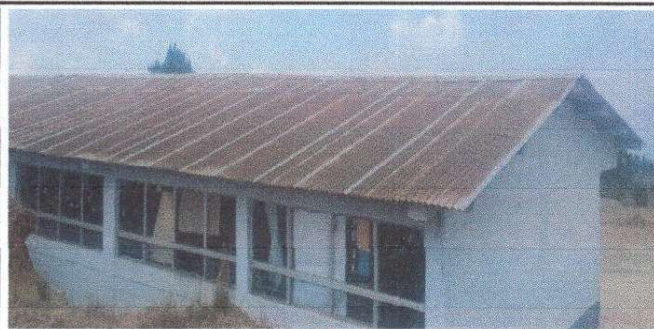
Foto1: Modulo 1 Sustitucion de lamina, por lamina troquelada calibre 26
