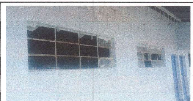
Foto 6: Modulo 2 sustitucion de balcones de metal
