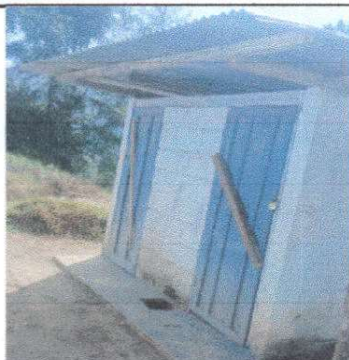
Foto 7: Modulo 1 Sustitución de puerta
