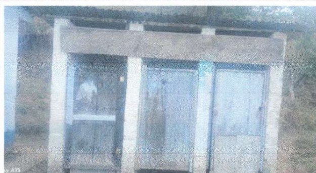
Foto 9: Sustitución de soporte de estructuras de madera por metal
