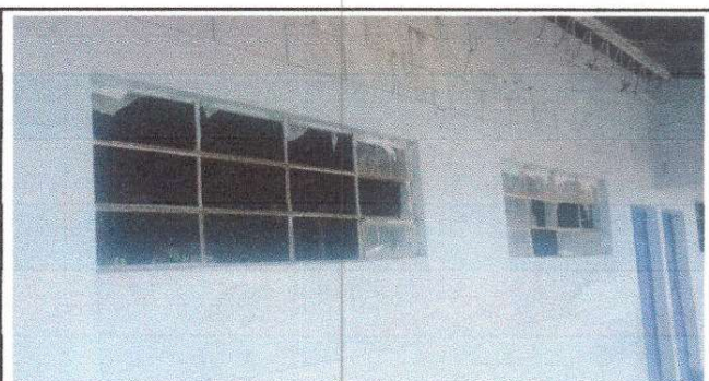
Foto 4: Sustitucion de vidrios
