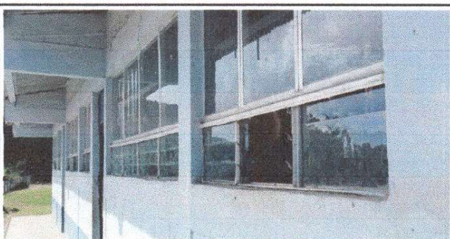
Foto 5: Modulo 1 sustitucion de balcones de metal
